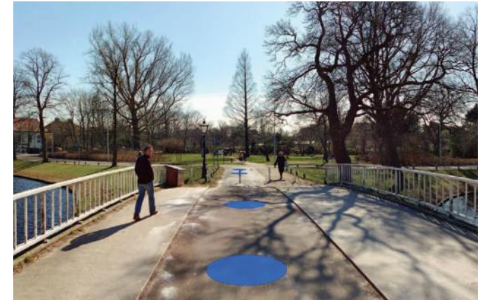
Het sportpark ligt naast de Van Disselbrug die van de binnenstad naar het sportpark leidt, maar de route loopt niet door.
