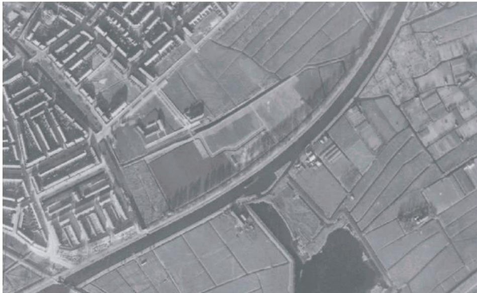
Luchtfoto met aanleg Burggravenlaan en eerste contouren Roomburgerpark.
